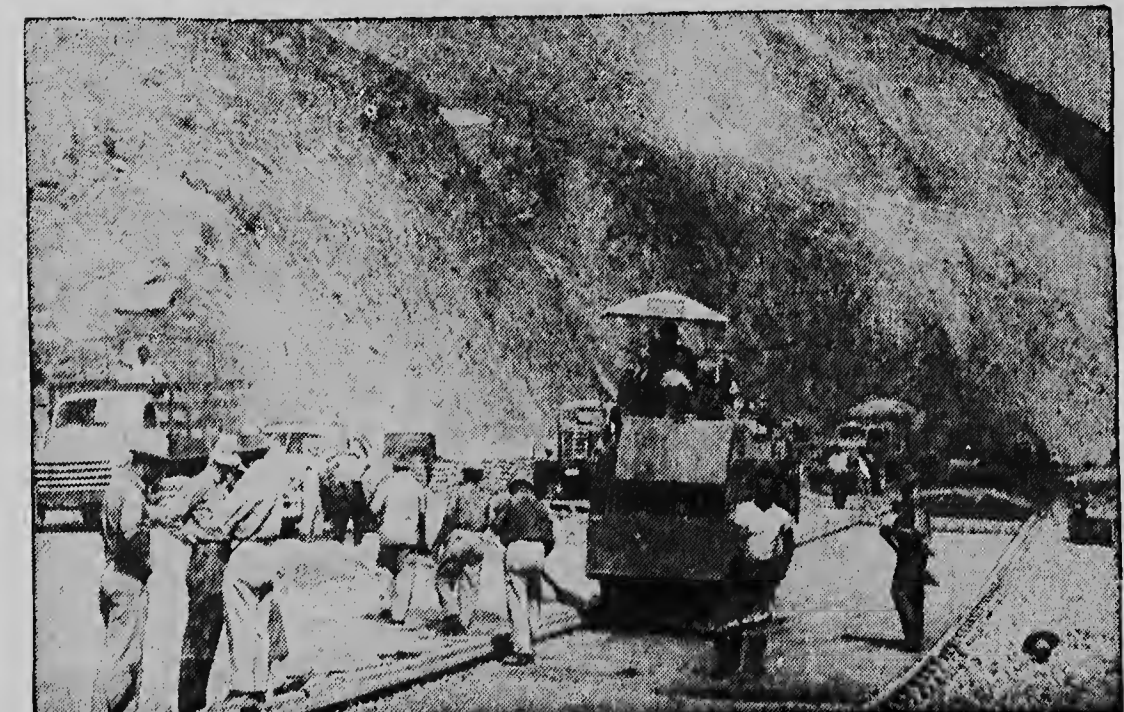
De dag voor de openstelling waren nog op vele plaatsen arbeiders koortsachtig bezig het grote werk te voltooiën.
